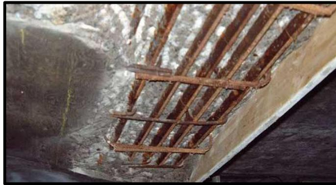
图 1: 混凝土中钢筋的腐蚀<sup>[2]</sup>
