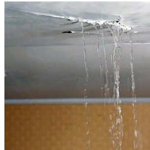
图 7: 屋顶渗漏 [9]
