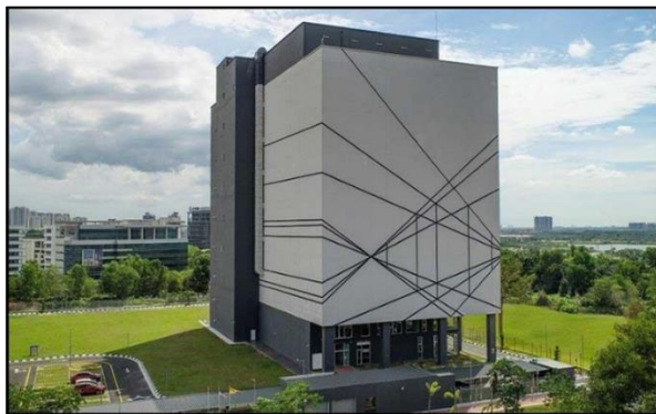
图 2: 位于布城 (Putrajaya) AIMS 数据中心
