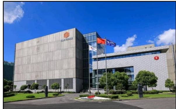
图 3: 柔佛的 Nusajaya 科技园数据中心 [11]
