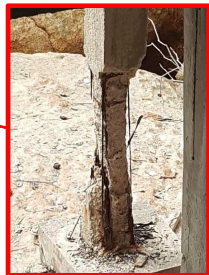
图 3: 沿海建筑物的柱子严重被腐蚀，钢筋完全损坏
