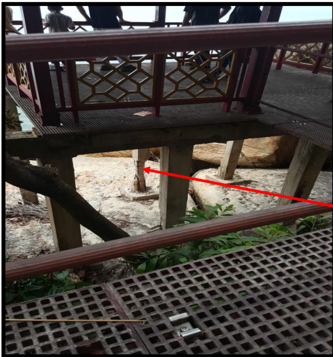
图 3: 沿海建筑物的柱子严重被腐蚀，钢筋完全损坏
