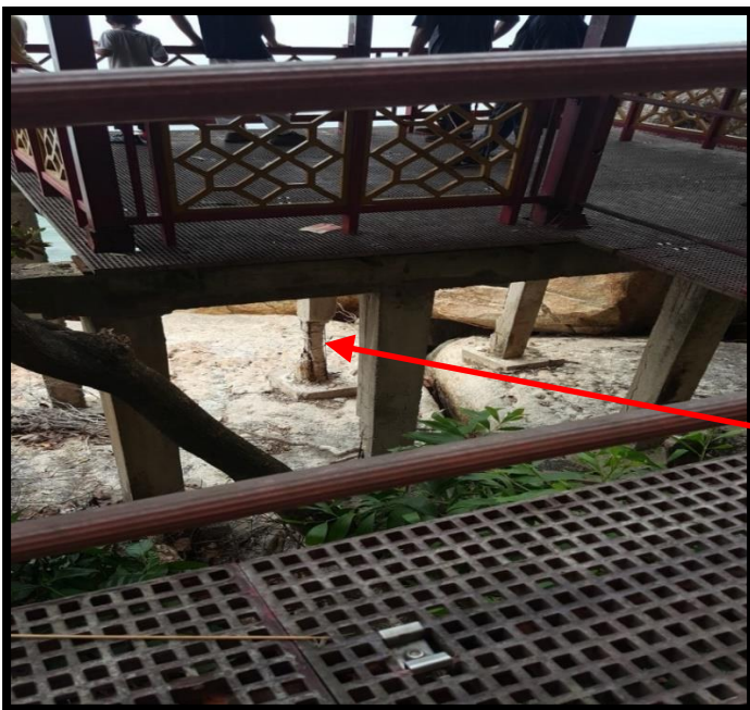
Gambar 3: Tiang Yang Rosak Dengan Kehilangan Bar Keluli yang Banyak di Bangunan Pesisir
