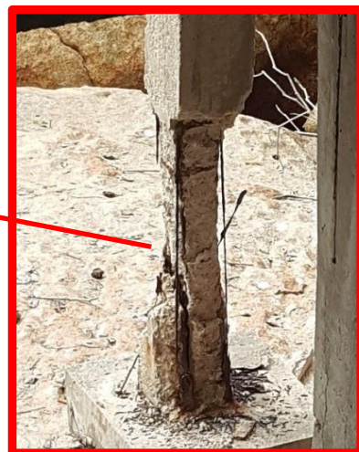
Gambar 3: Tiang Yang Rosak Dengan Kehilangan Bar Keluli yang Banyak di Bangunan Pesisir
